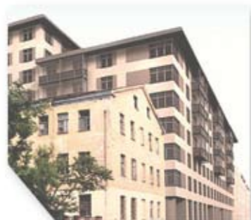
Жилой комплекс ул. Егорова, 35
